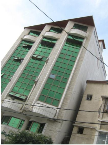
شكل رقم (٧٨-٤) منظر عام لمبنى المستشفى وعلاقته
