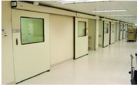
شكل رقم (٣-٣٤) صورة توضح أبواب غرف العمليات نوع منزلق أتوماتيكياً
