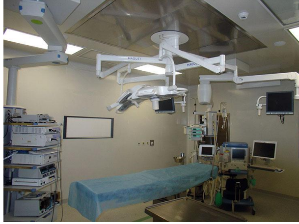
شكل رقم (٦٤-٣) صورة توضح نظام التدفق الصفائحي أعلى طاولة العمليات
