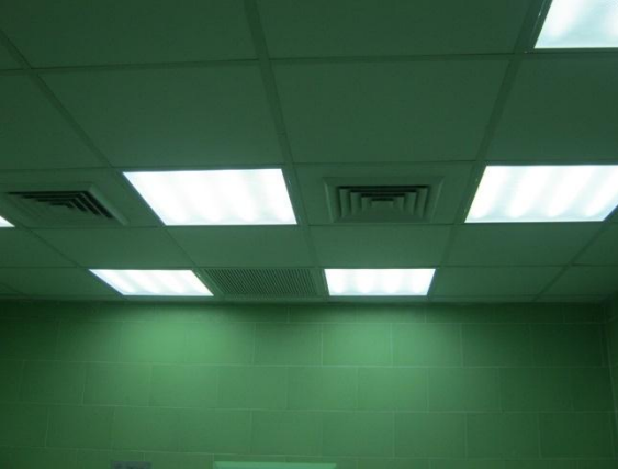
شكل رقم (١١-٤) صورة توضح سقف غرفة العمليات المصدر: الباحثة
