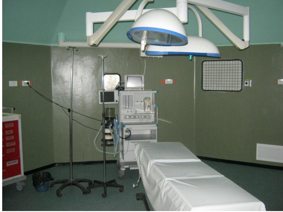
شكل رقم (٣-٣٥) صورة توضح تشطيب أرضية (antistatic Pvc. floors) وحوائط غرفة العمليات (Pvc. walls) المصدر: الباحثة
